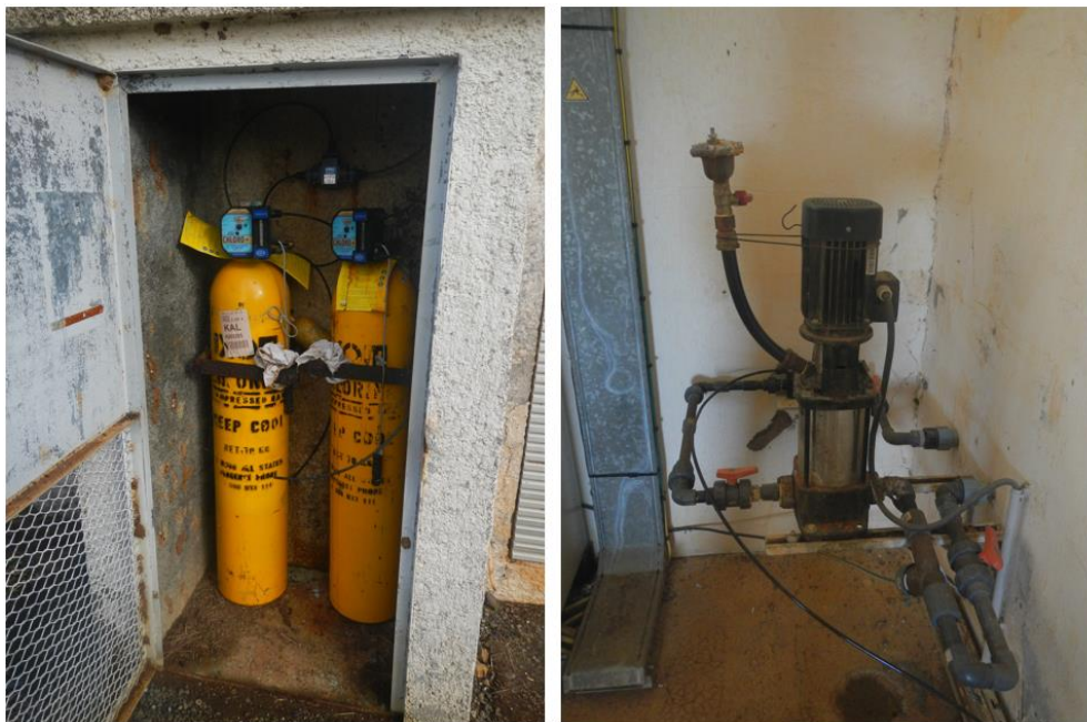
Figure 26 Système de chloration (local chlore gazeux & hydro injecteur)
