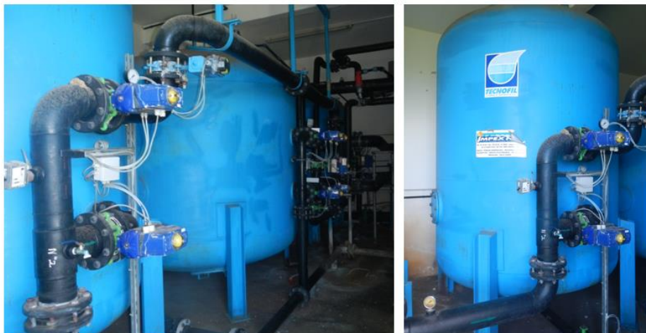
Figure 28 Tour d'oxydation et filtre à sable
