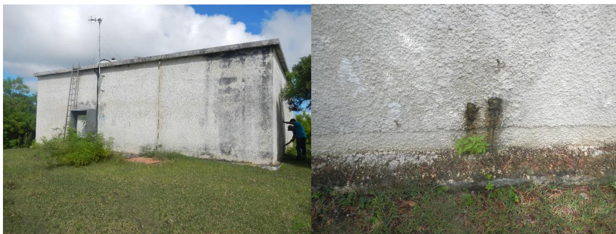
Figure 20 Vue d'ensemble du réservoir 1 et problème d'étanchéité identifié
