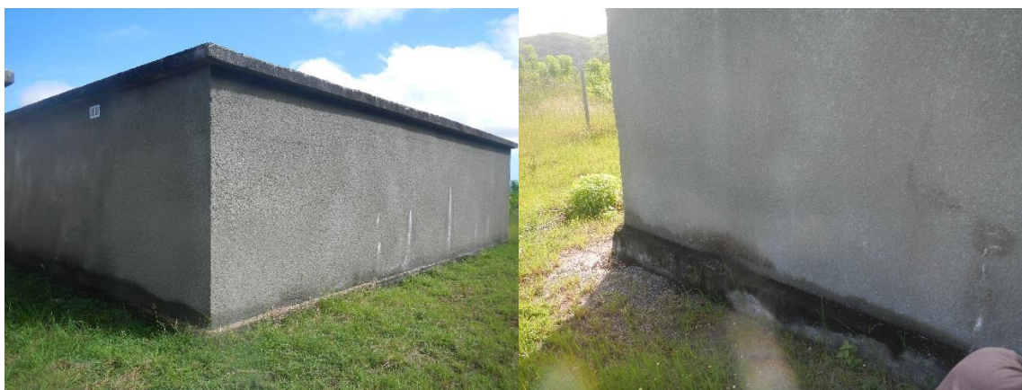
Figure 23 Vue d'ensemble et défaut d'étanchéité sur le réservoir 3 de Ouaménie-Bouraké
