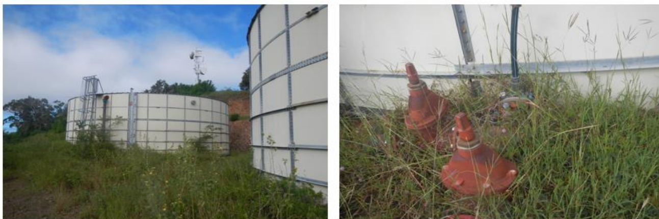
Figure 36 Photographies des deux réservoirs et du dispositif vidange/distribution
