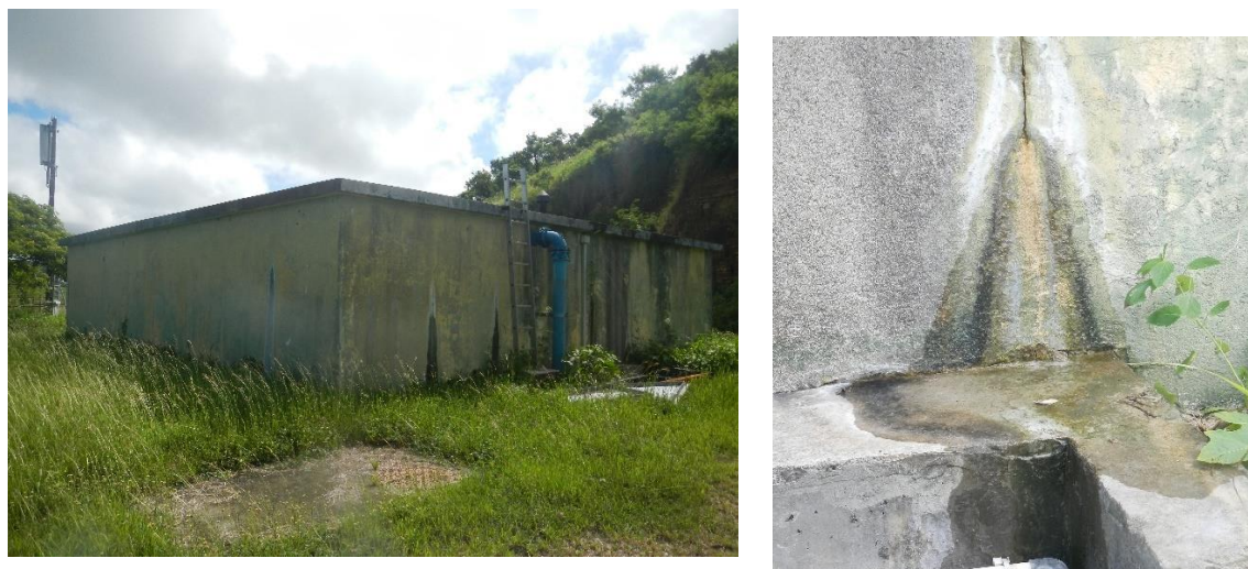
Figure 21 Vue d'ensemble et fuite apparente du réservoir 1 de Ouaménie-Bouraké
