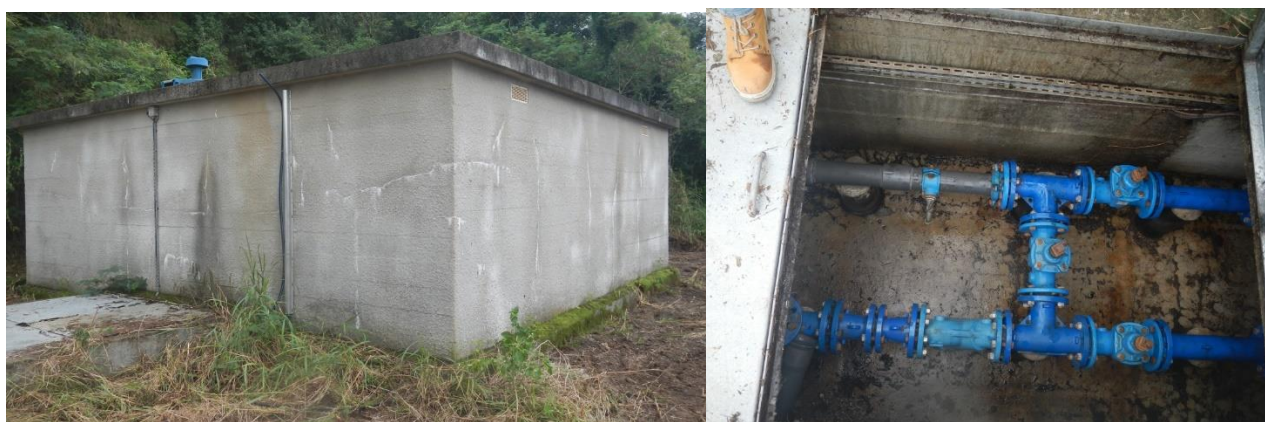
Figure 55 Vue d'ensemble et chambre des vannes du réservoir de Ouitchambo
