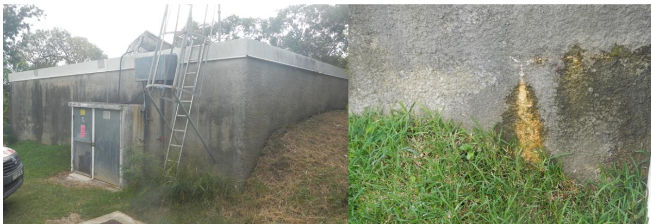
Figure 41 Vue d'ensemble du réservoir de Tomo et problème d'étanchéité sur béton
