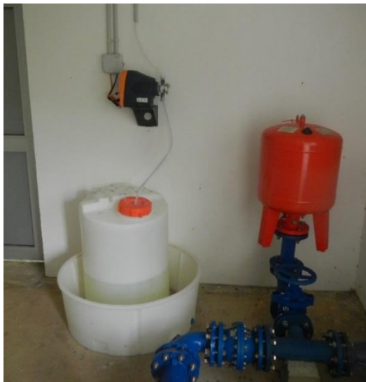
Figure 27 Bac de rétention de la Javel et système d'asservissement dans le local
