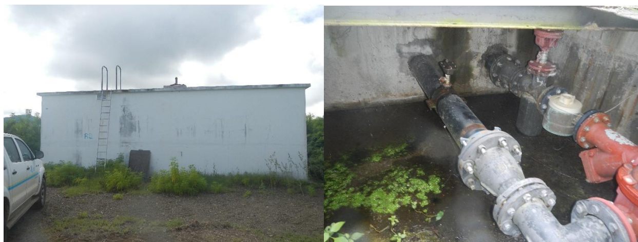
Figure 19 Vue d'ensemble du réservoir 2 et de la chambre des vannes associée
