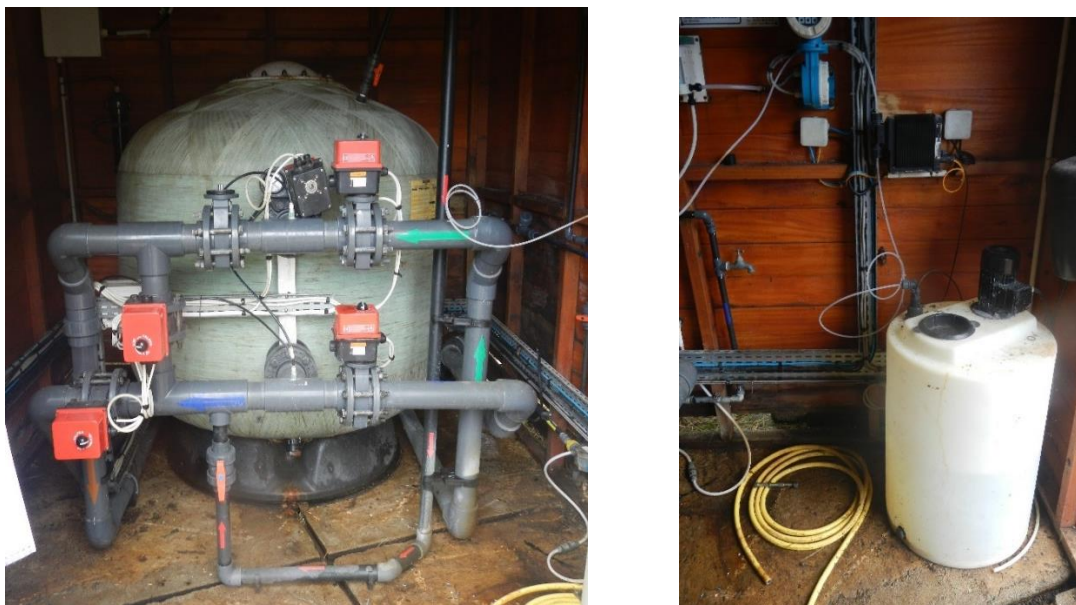
Figure 56 Unités de filtration et de javellisation
