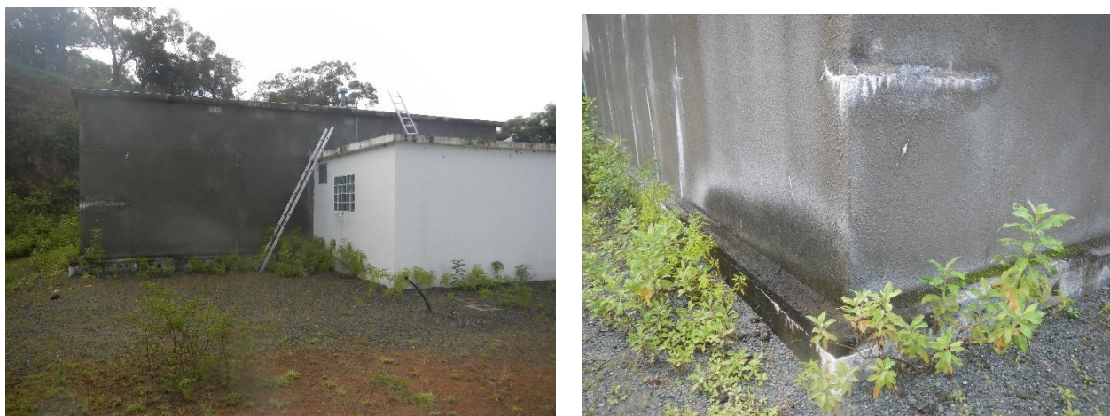
Figure 18 Vue d'ensemble du réservoir et défauts d'étanchéité apparents
