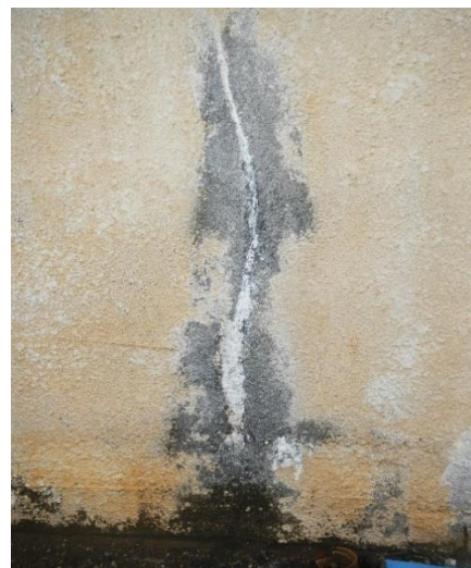
Figure 16 Vue d'ensemble de la bâche de reprise de la Ouenghi et trace de calcite
